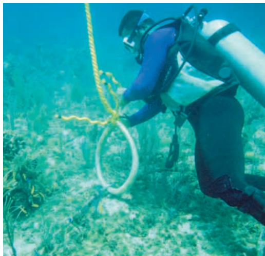
アンカーによるダメージを防ぐため、サンゴ礁に係留ブイを設置するダイバー
