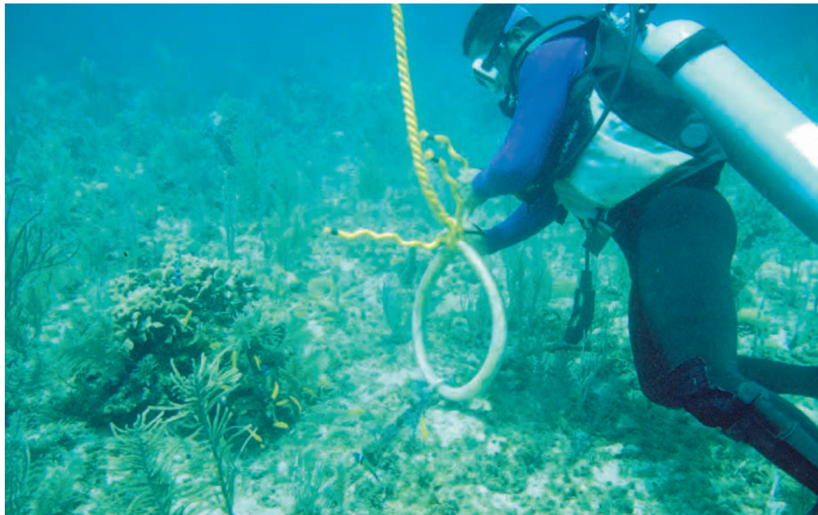
サンゴ礁がアンカー（錨）で破壊されないように、係留ブイを設置するダイバー
